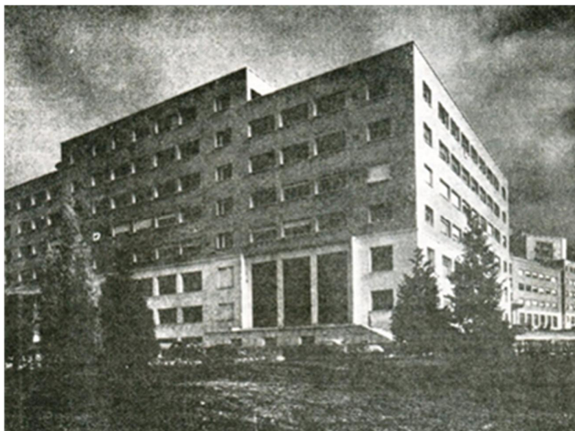
Figura 5. La ampliación del Sector de Investigación en la zona Oeste del Instituto, próxima al Instituto de Cultura Hispánica.
